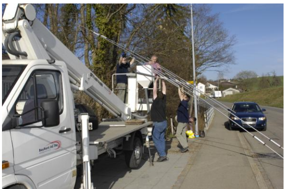
Verlad des Beams auf die Kanzel
